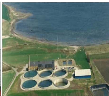
Figur 14. Kongeåens modeldambrug type 3. Produktionsenhederne omfatter 3 sektioner, der hver består af 2 beton raceways med mikrosigter (maskestørrelse 74 µm) foran biofilter sektionerne (forgrunden). I baggrunden til venstre ses plantelagunerne bestående af de tidligere jorddamme og indløbs- og udløbskanaler (Svendsen et al., 2008). Foto: Lars M. Svendsen.
