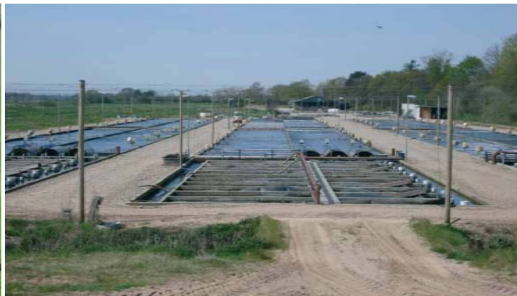
Figur 14. Kongeåens modeldambrug type 3. Produktionsenhederne omfatter 3 sektioner, der hver består af 2 beton raceways med mikrosigter (maskestørrelse 74 µm) foran biofilter sektionerne (forgrunden). I baggrunden til venstre ses plantelagunerne bestående af de tidligere jorddamme og indløbs- og udløbskanaler (Svendsen et al., 2008). Foto: Lars M. Svendsen.
